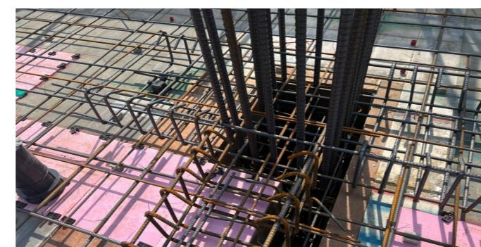
무량판구조가 적용된 방화동 행복주택에서 철근 배근을 확인하는 SH공사 전문기관을 통해 전단보강 철근탐사, 콘크리트 비파괴 압축강도 시험 등 정밀조사를 할 계획이다.
