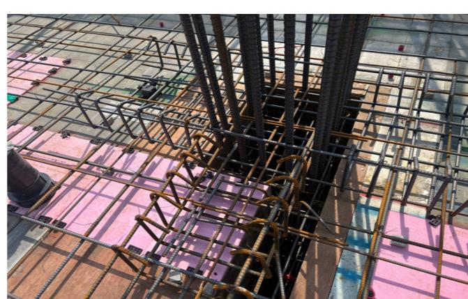
무량판구조가 적용된 방화동 행복주택에서 철근 배근을 확인하는 SH공사 전문기관을 통해 전단보강 철근탐사, 콘크리트 비파괴 압축강도 시험 등 정밀조사를 할 계획이다.
